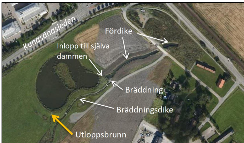
Figur 1. Översiktbild av Kungsängsdammen med beskrivning av dammen, modifierad efter Arnlund (2014). Foto: Uppsala Vatten.
