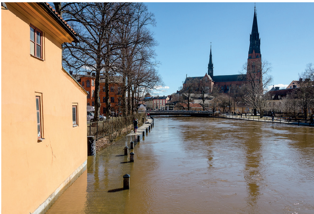
Figur 2-3. Översvämnning av Fyrisån 2013.
