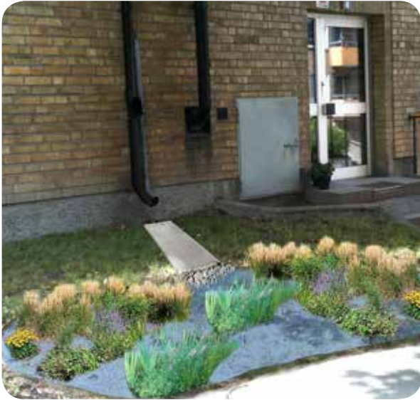
Ett fotomontage där stuprörskastare leder dagvattnet via rännalplattor till en översilningsyta. (Källa: Dagvattenutredning Mörbyviken, Sweco)
